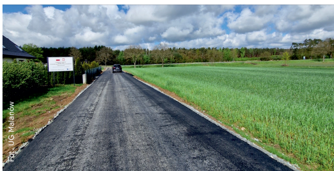
Zmodernizowana droga w miejscowości Targówka
